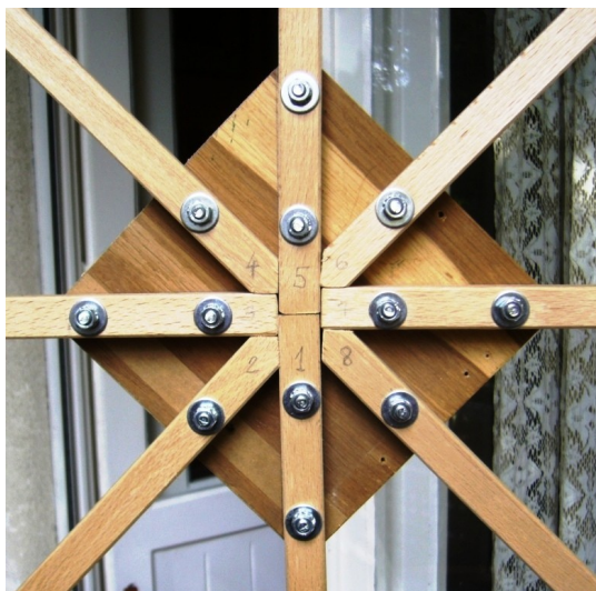
4. ábra. A faváz csavarokkal összefogott középrésze
